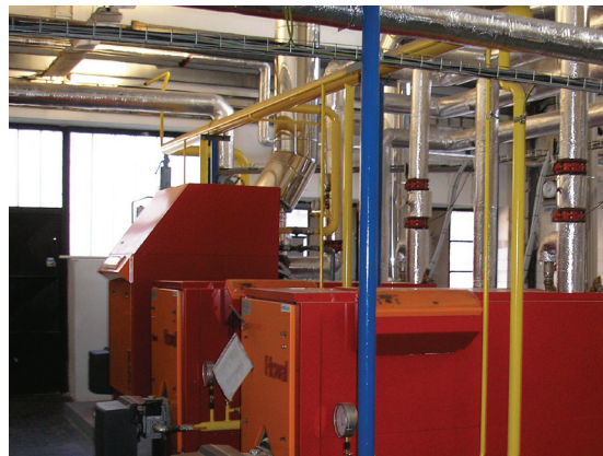
stav po rekonstrukci
