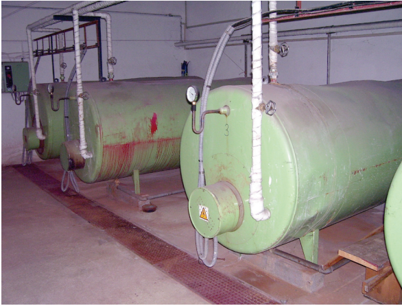
4 akumulční ohříváky teplé vody o celkovém objemu 12 m 3 , s el. příkonem 99 kW
