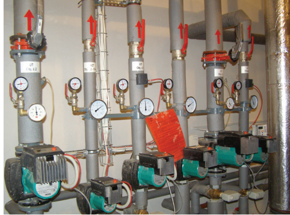
stav po rekonstrukci
