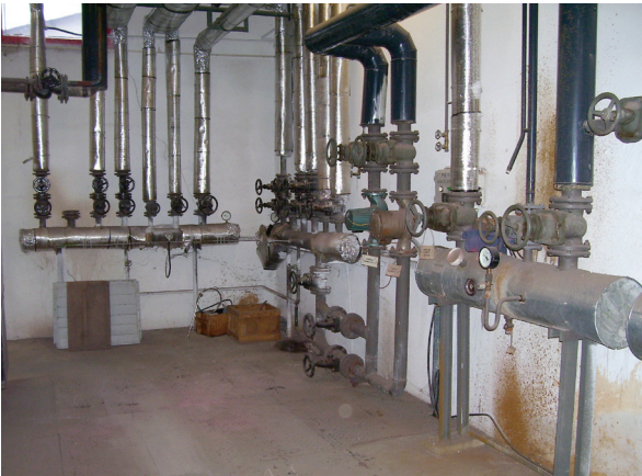
původní rozdělovač a sběrač
