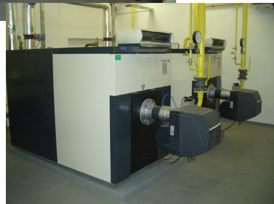
obr. 3) plynové teplovodní kotle De Dietrich 2x 409 kW
